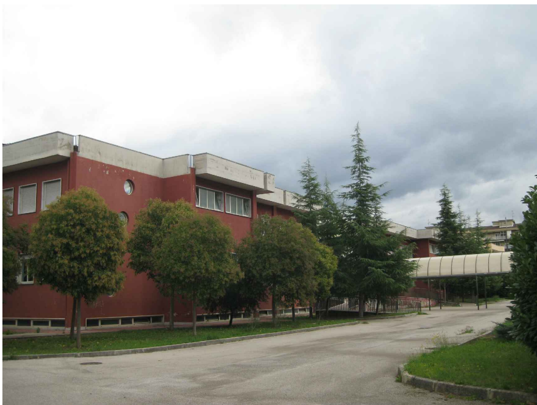
immagine 1 - vista del fronte anteriore con l'accesso all'edificio
