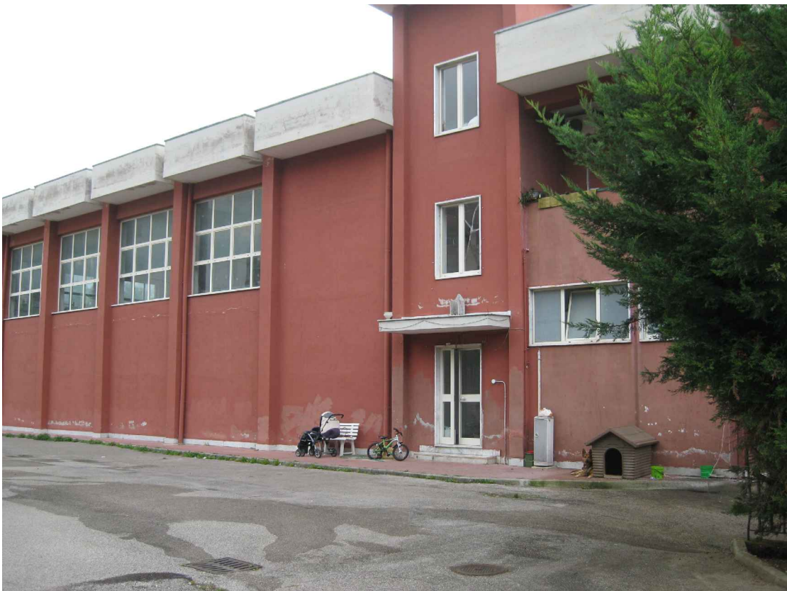
immagine 5 - particolare del fronte Nord-Ovest con l'accesso del custode
