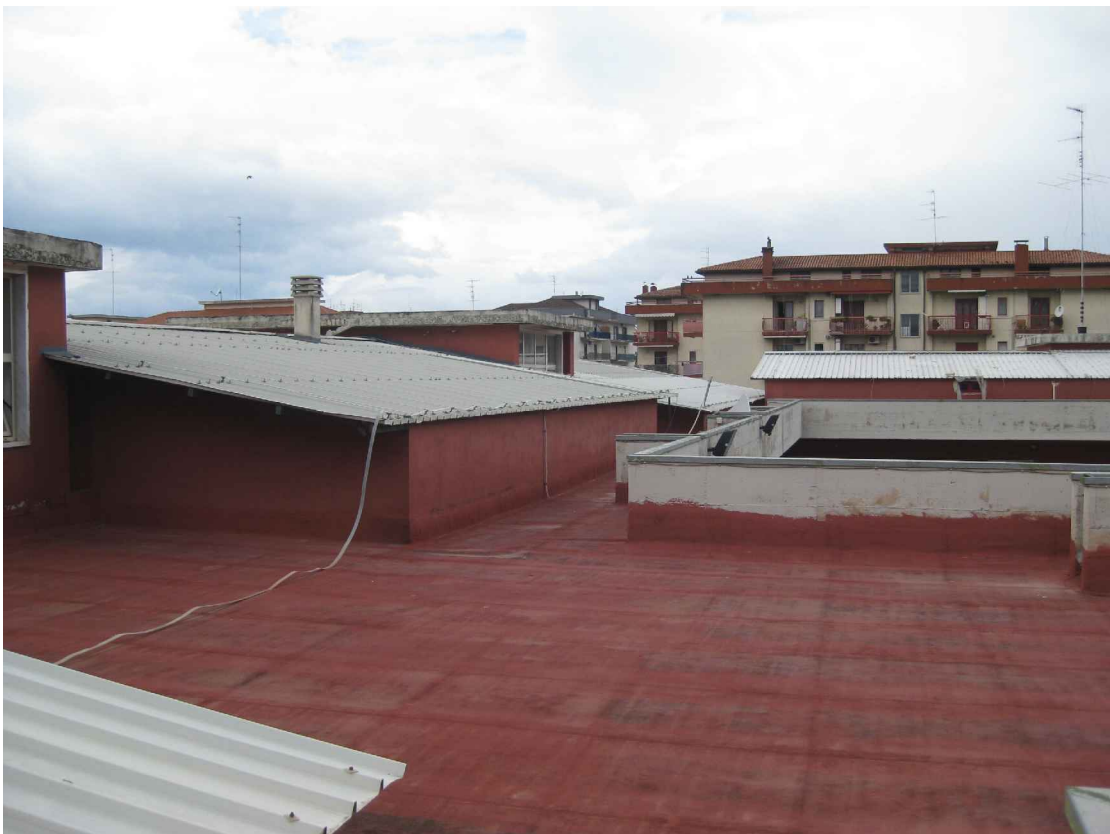
immagine 7 - vista della copertura del blocco centrale dell'edificio
