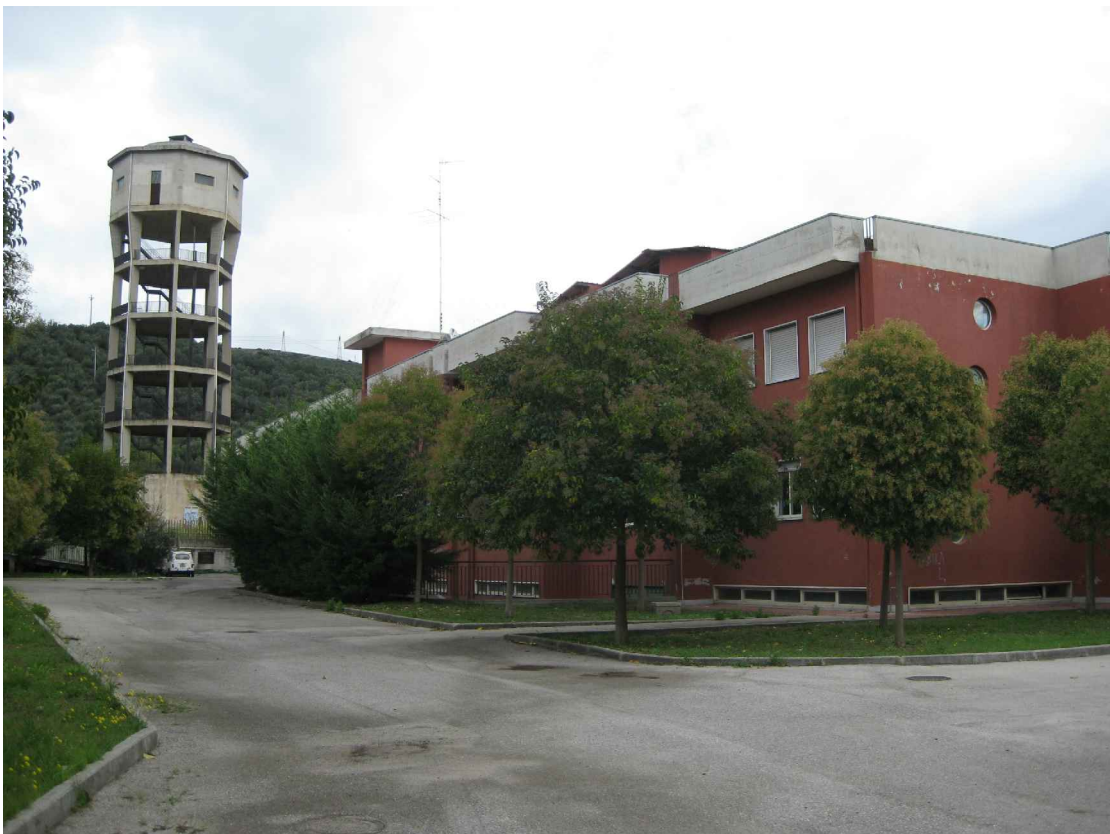
immagine 3 - scorcio Nord-Ovest dell'edificio
